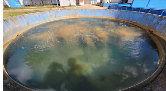
Início do processo de lavagem de um filtro existente, injeção de ar comprimido.
