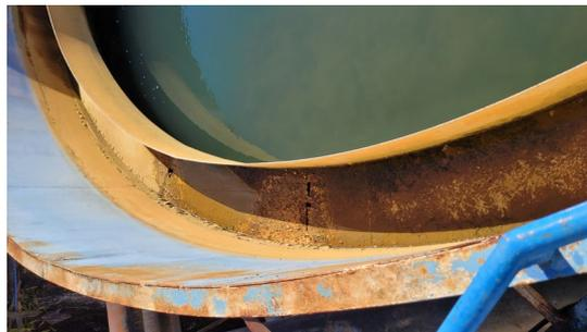
Canaleta de coleta da água de lavagem dos filtros existentes, em processo avançado de corrosão.
